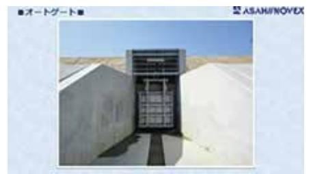
Aの写真は大震災の際、東北地方にすでに設置されていたオートゲートです。左右の手摺りは少し壊れていますが、扉はきちんと閉まっており、津波の遡上をブロックしていたことがわかります。
